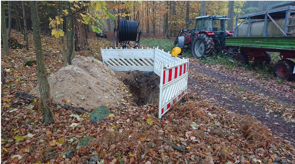
Mit dem **Trenchingverfahren** werden die Kabel oder Leerrohre direkt während des Aufschlitzens des Bodens verlegt; die Einsandung erfolgt automatisch:
